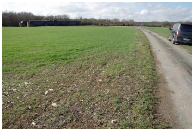
Piste à renforcer au droit d'E5 (14/02/2017)
